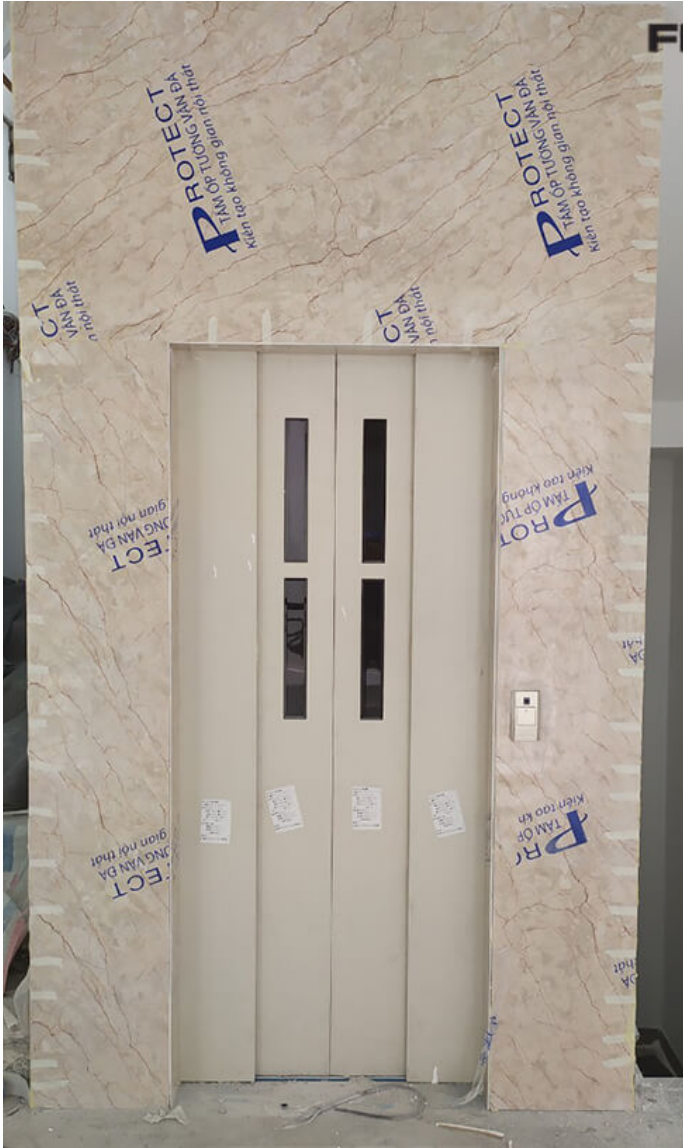
DỰNG KHUNG THÉP + ỐP NHỰA PVC VÂN ĐÁ (TIẾT KIỆM CHI PHÍ HƠN)
